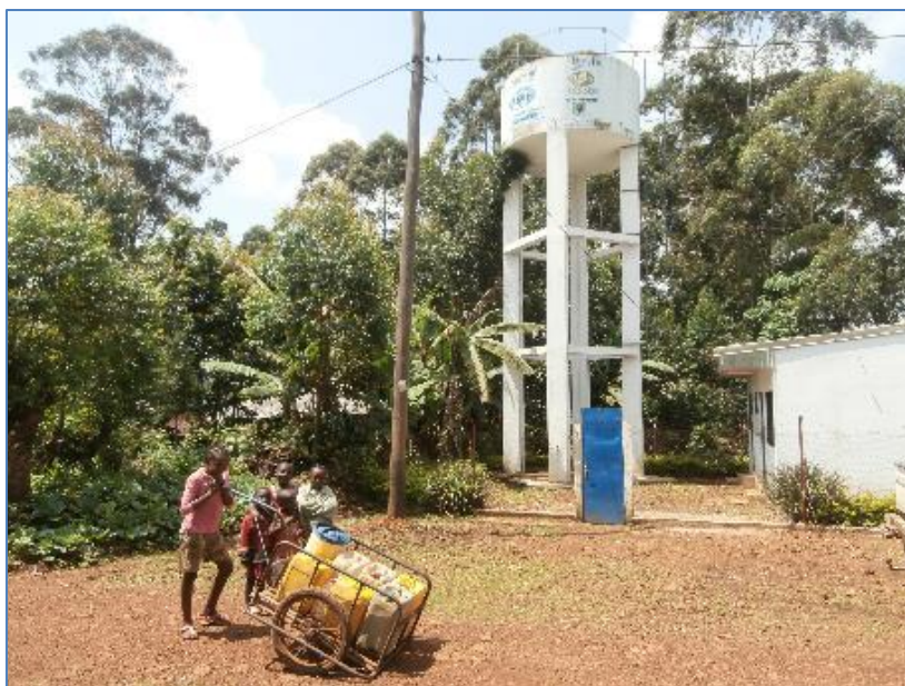
Réservoir d'eau potable de Sa'ah Batsingla
