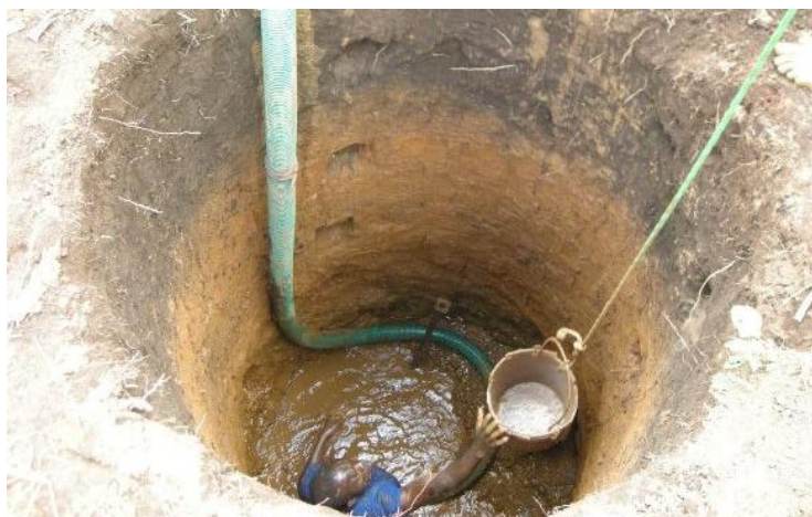
(Construction du puits de captage de Sa'ah)
