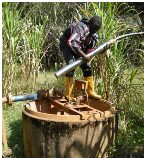
(Essai de Pompage sur le puits de SCANWATER)
