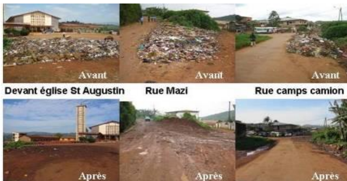
(Nettoyage de dépôts anarchiques avant et après)
