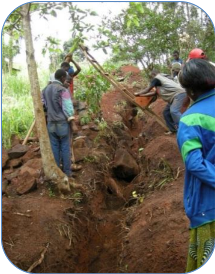
Château d'eau de Sa'ah Batsingla
